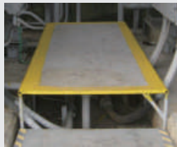
設置台階邊緣黃漆標示
