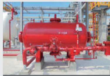
消防泡沫儲槽
