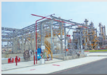
卸車站撒水系統
