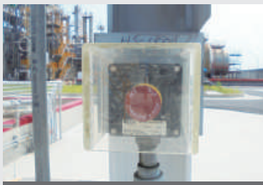
現場緊急隔離閥按鈕
