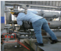
現場作業人員於工作高平台上滑落
