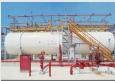
儲槽自動撒水系統
