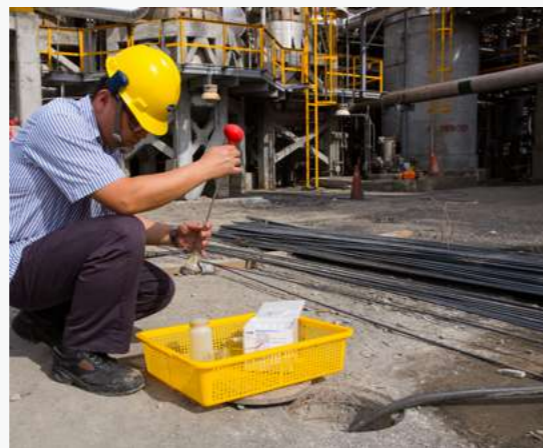
設置地下水井監測
